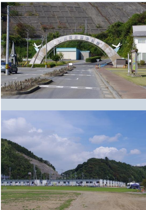
追波川運動公園(上)と多目的団地全景(下)
